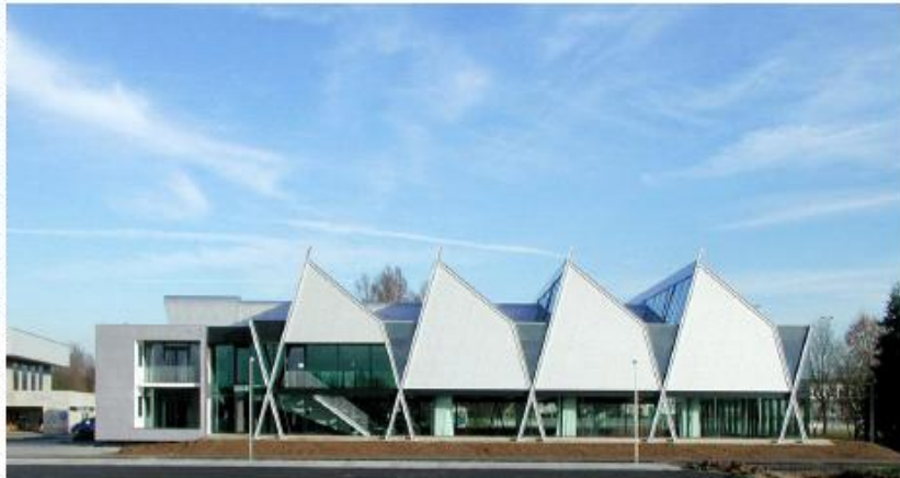
Dreifeldsporthalle, Großostheim, Dierks Blume Nasedy Architekten, Ing. Büro Rödel, New Building, Gymnasium, 2000
